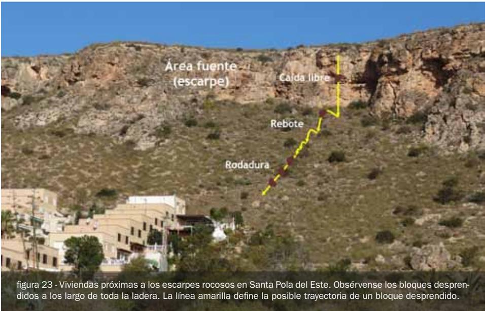
figura 23 - Viviendas próximas a los escarpes rocosos en Santa Pola del Este. Obsérvense los bloques desprendidos a los largo de toda la ladera. La línea amarilla define la posible trayectoria de un bloque desprendido.
