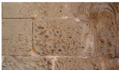
figura 24 - Detalle del proceso de alveolización que sufren las rocas de la fachada de la iglesia de Santa María. Compárese con la figura 18.
