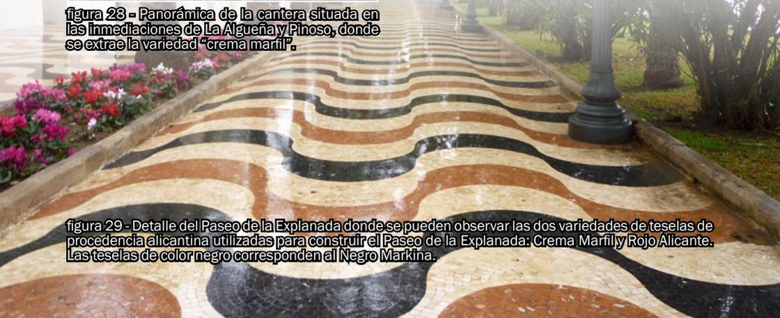
figura 29 - Detalle del Paseo de la Explanada donde se pueden observar las dos variedades de teselas de procedencia alicantina utilizadas para construir el Paseo de la Explanada: Crema Marfil y Rojo Alicante. Las teselas de color negro corresponden al Negro Markina.
