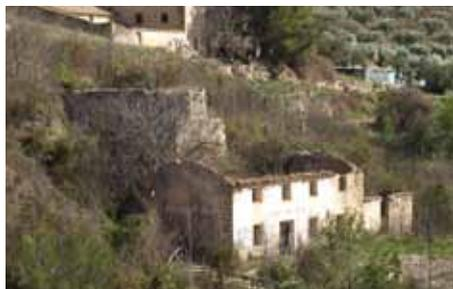
figura 45 - Los molinos harineros de turbina de eje vertical precisaban de un gran depósito de agua -el cubo- con una altura en torno a los 12 metros y 1,50 metros de diámetro, para que las aguas salieran con gran presión por el orificio situado en su punto inferior e impulsarían la turbina que hacía girar la gran muela de piedra del molino.
