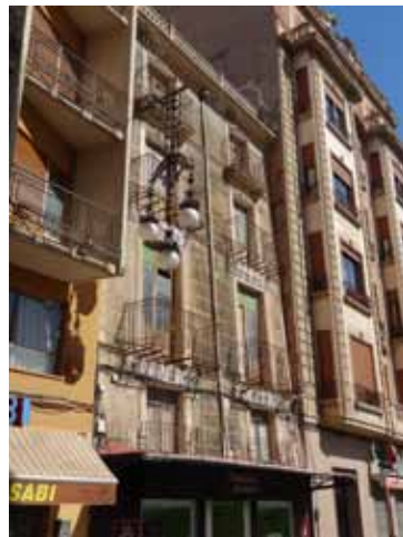
figura x - Edificio basculado en Plaza Nueva (Orihuela), situada en las proximidades del río Segura.
